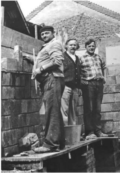
Іван Чендей з майстрами на будівництві хати, 1985 р.
